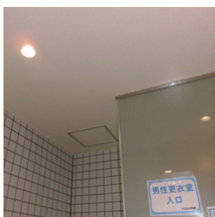
換気設備改修
